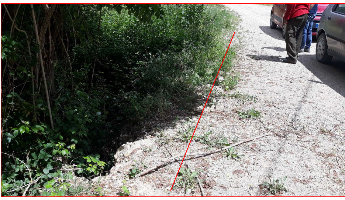
Foto 2: particolare b) installazione barriera sicurezza (lato valle)
