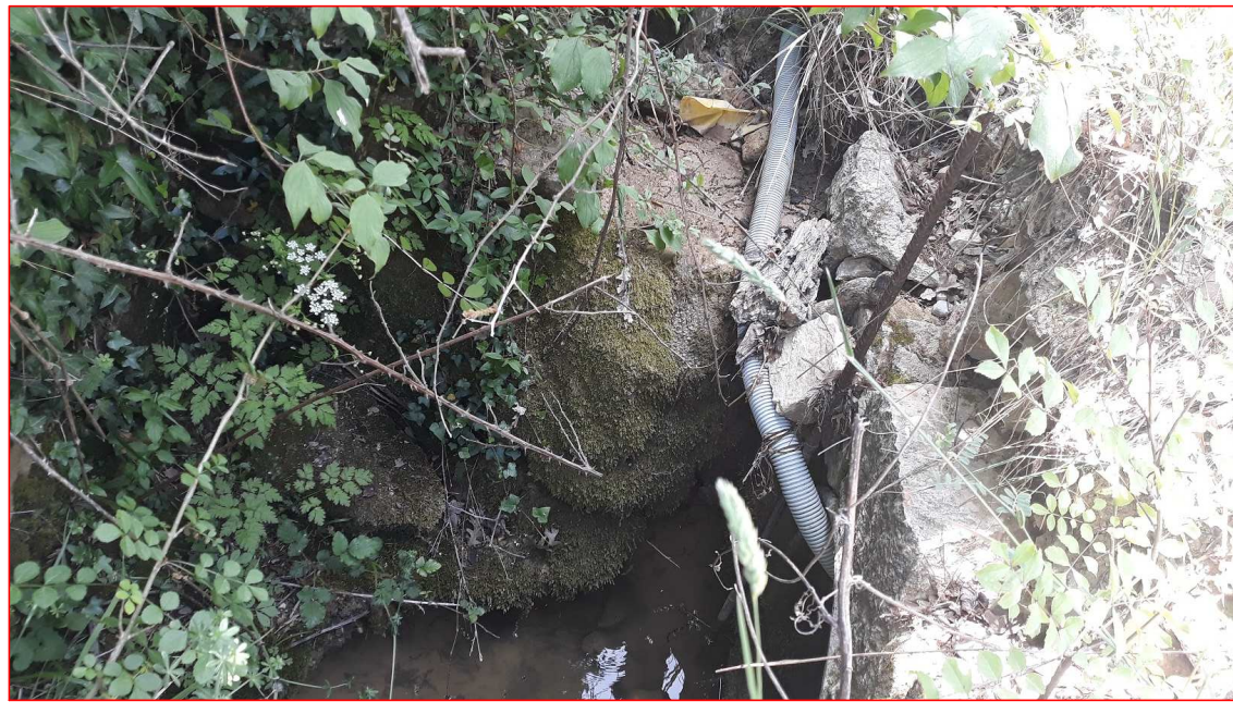
Foto 2: particolare b) installazione pozzetto d'ispezione
