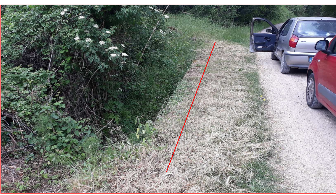
Foto 1: particolare a) installazione barriera sicurezza (lato monte)
