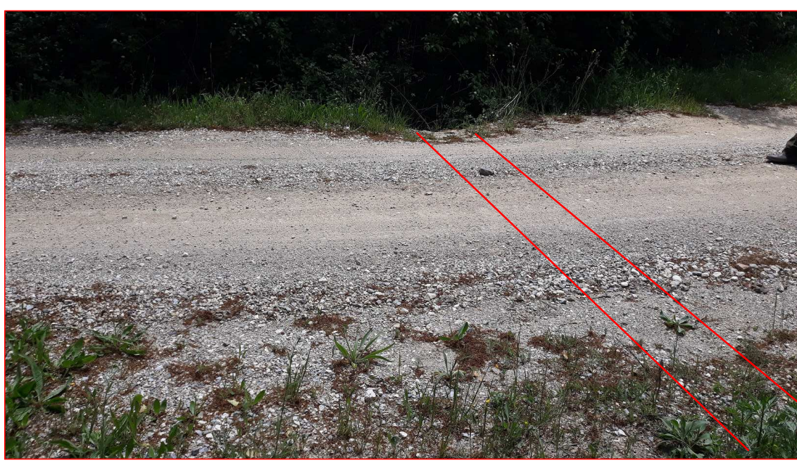
Foto 1: particolare a) sostituzione tubo in cemento lesionato
