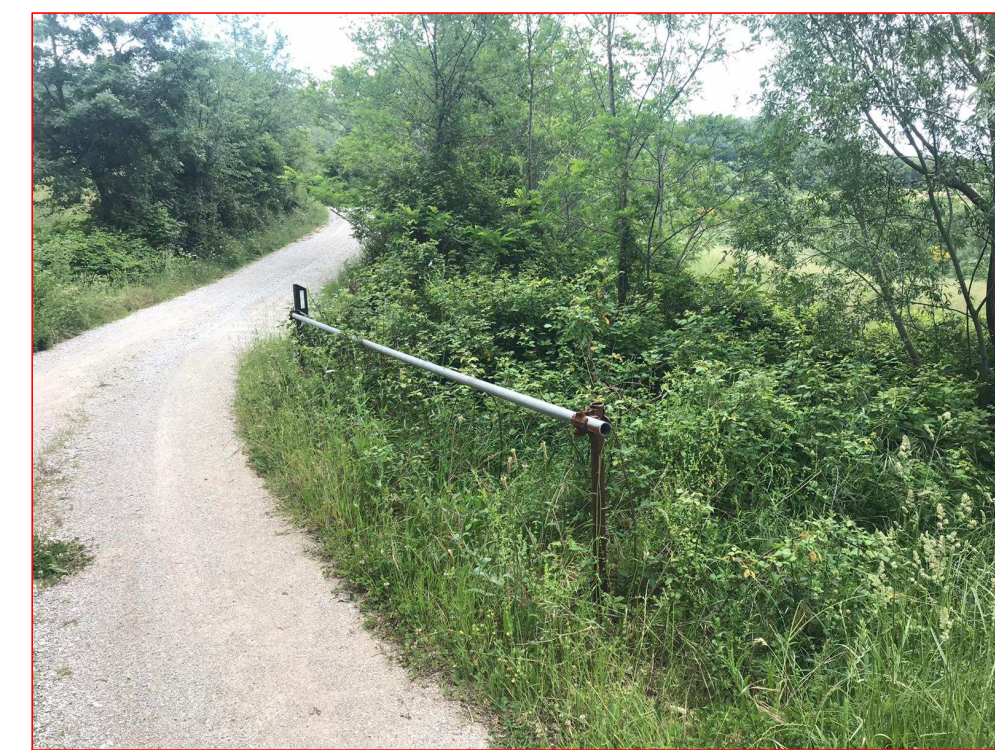
Foto 1: particolare a) posa in opera di barriera di sicurezza (lato valle)
