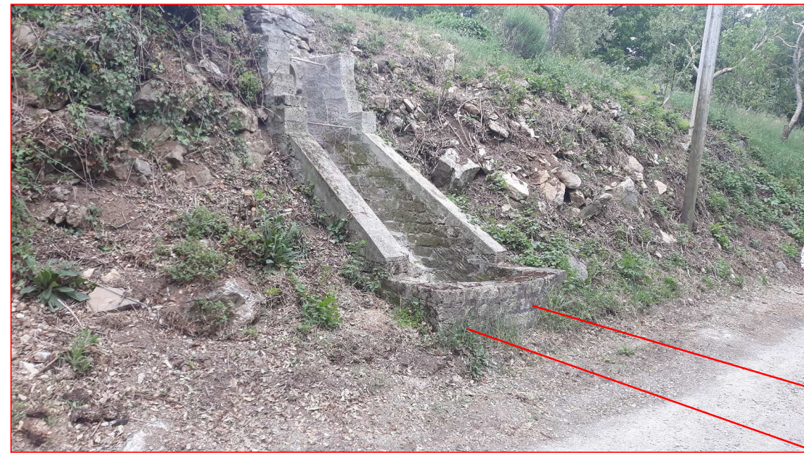
Foto 1: particolare a) tratto sostituzione tubo in cemento lesionato
