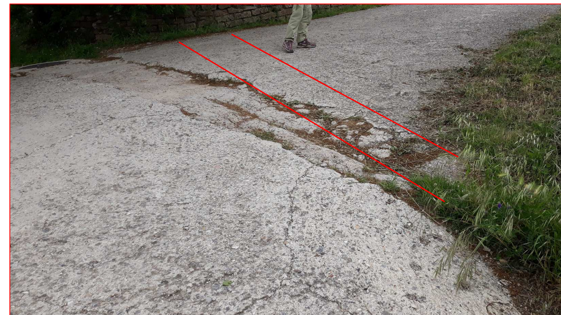
Foto 1: particolare a) installazione griglia per deflusso acque meteoriche
