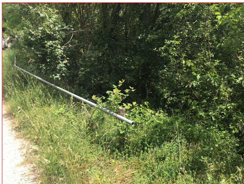
Foto 2: particolare b) posa in opera di barriera di sicurezza (lato valle)
