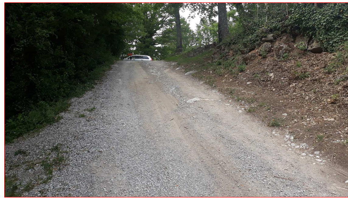
Foto 2: particolare b) tratto con pendenza eccessiva oggetto di cementificazione
