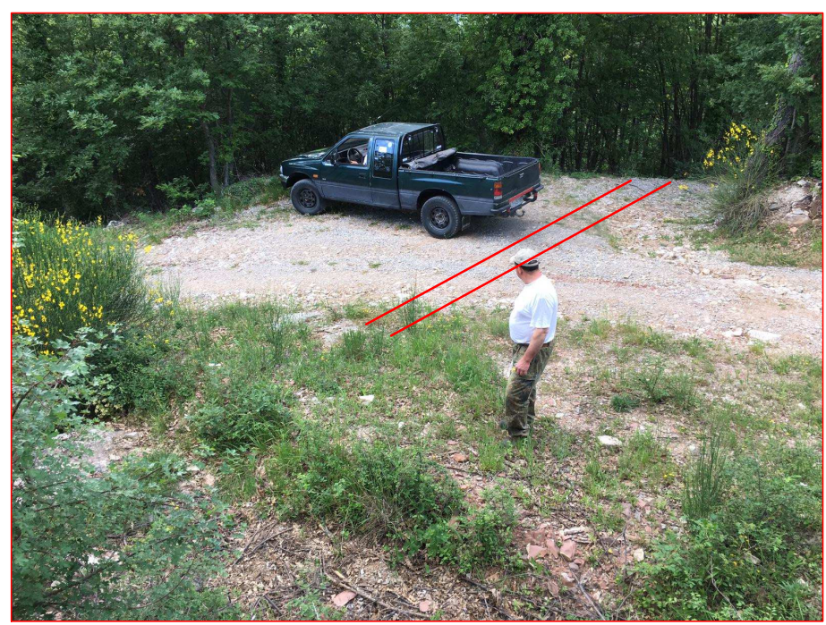
Foto 3: particolare c) inserimento tubo in pvc, 12 m
