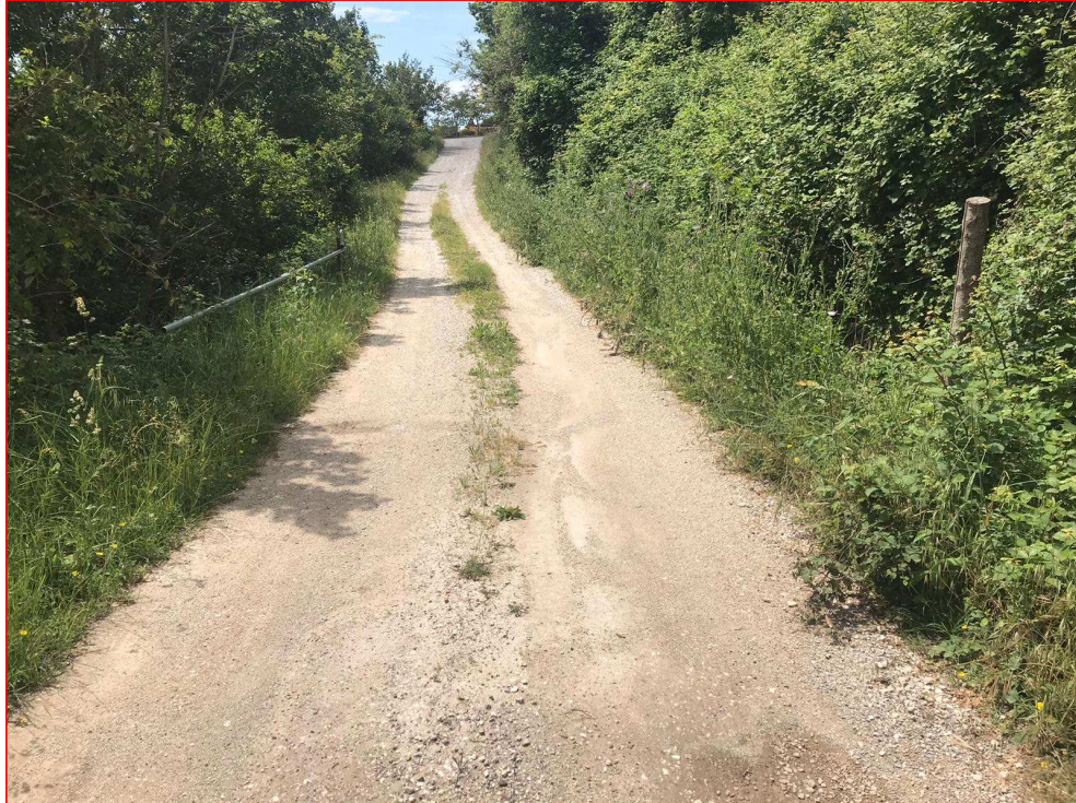
Foto 1: particolare a) posa in opera di barriera di sicurezza (vista strada)
